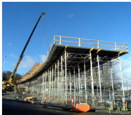
Hệ thống giàn giáo xây cất cầu ở Hoa Kỳ (Ảnh: Baker)
