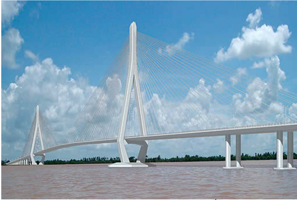
Mô hình cầu Cần Thơ nhìn từ thượng lưu bờ phía nam (Ảnh: Chodai Co.)
