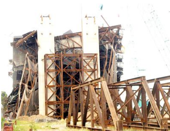
Sườn sắt đỡ sàn bê tông (Ảnh: Kiến Giang)
