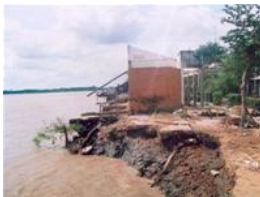
Sạt lở sông Giao Hòa (41)
