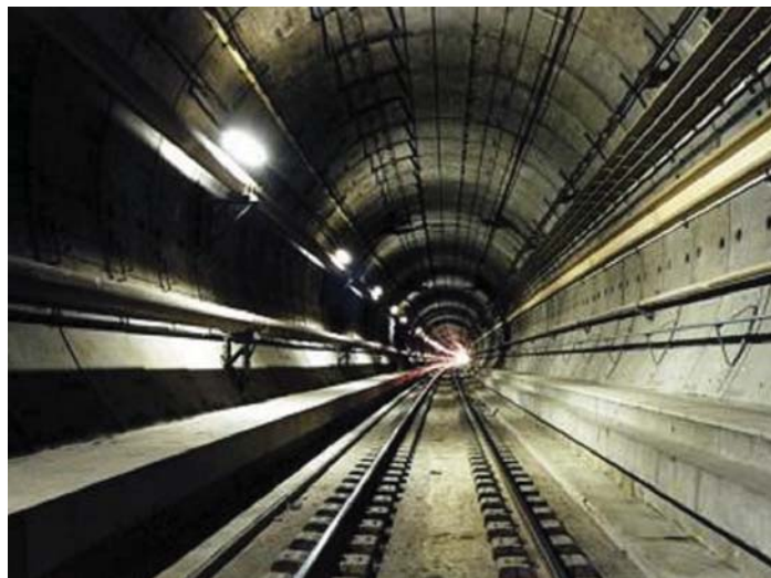
Đường hầm qua eo biển Manche
